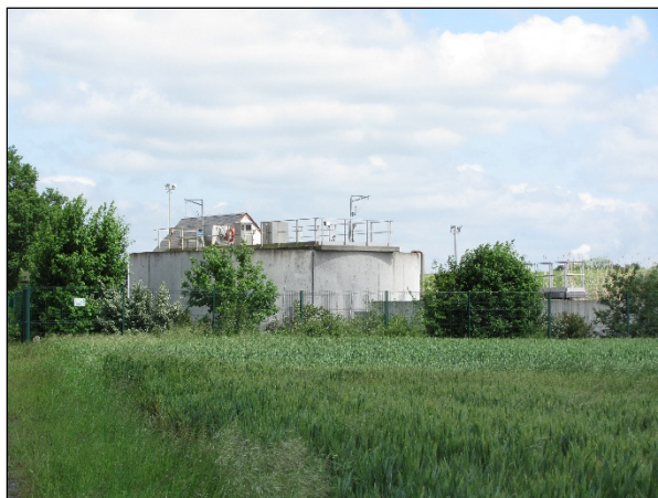
La station d'épuration
